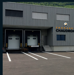
Quai de chargement
