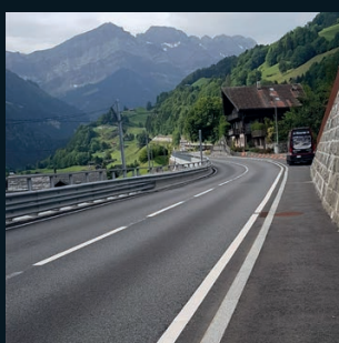
Ligne de sécurité et ligne de direction
